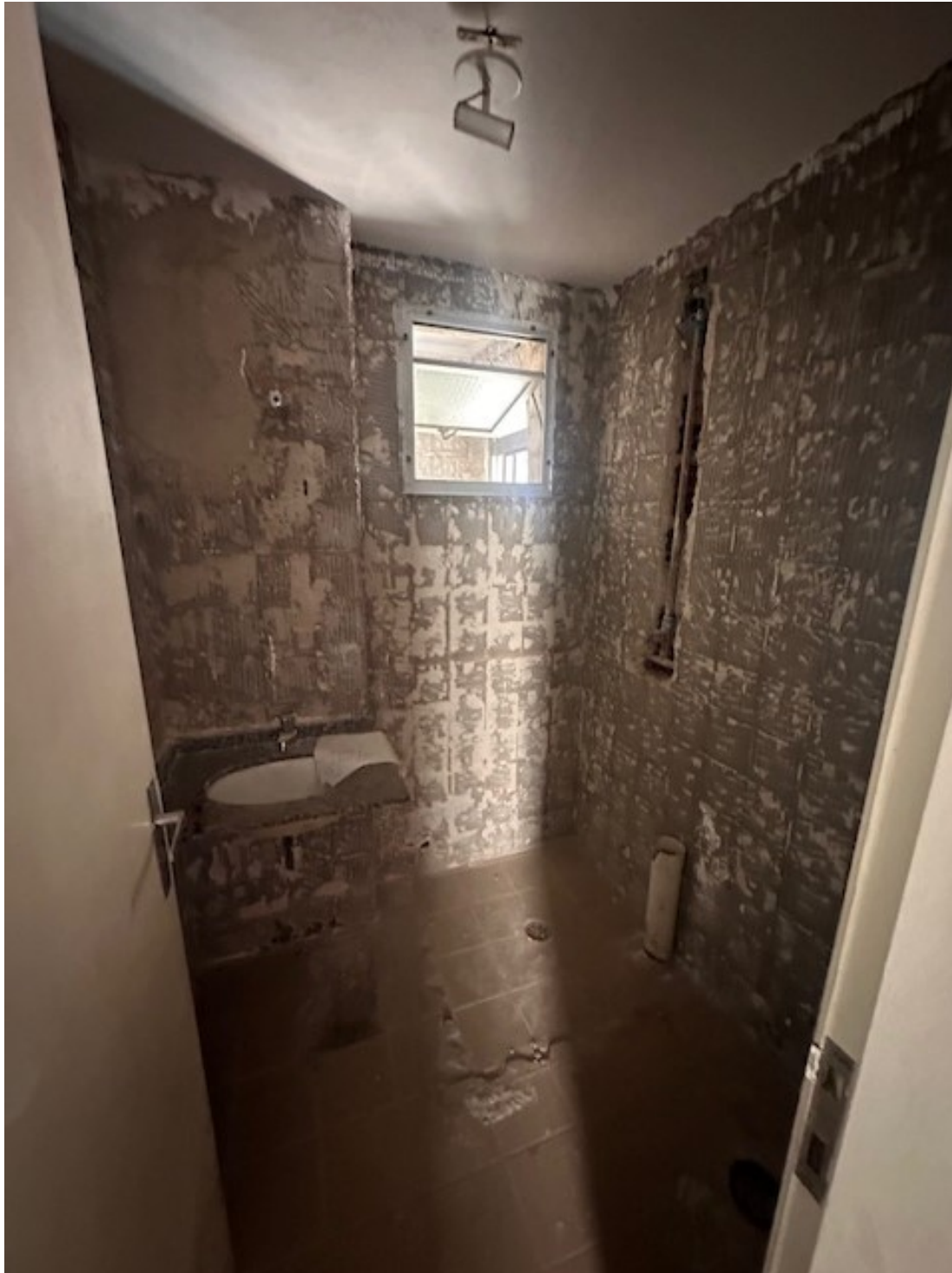
Foto 6: Vista do banheiro da unidade 44 do Bloco 6 do Condomínio Morada dos Pássaros – avaliando.
