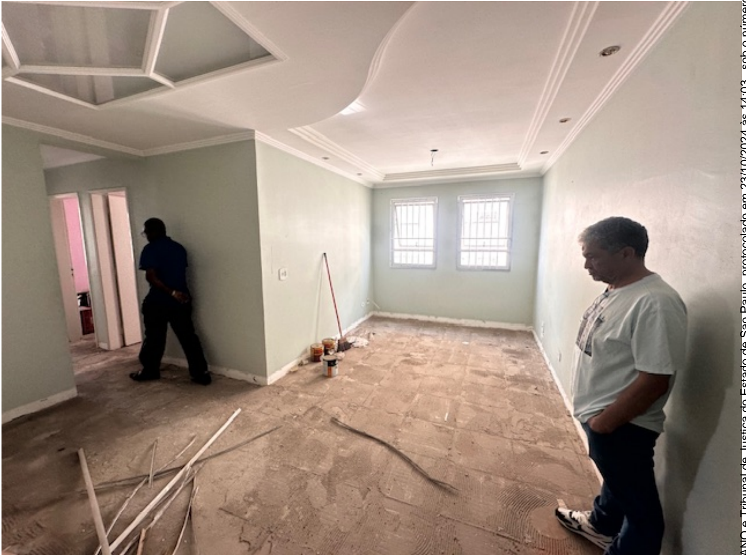
Foto 5: Vista da sala da unidade 44 do Bloco 6 do Condomínio Morada dos Pássaros – avaliando.
