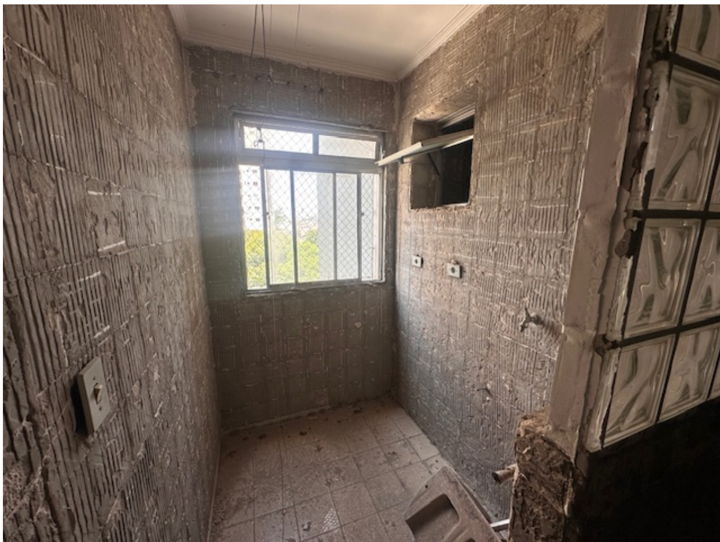
Foto 4: Vista da lavanderia da unidade 44 do Bloco 6 do Condomínio Morada dos Pássaros – avaliando.
