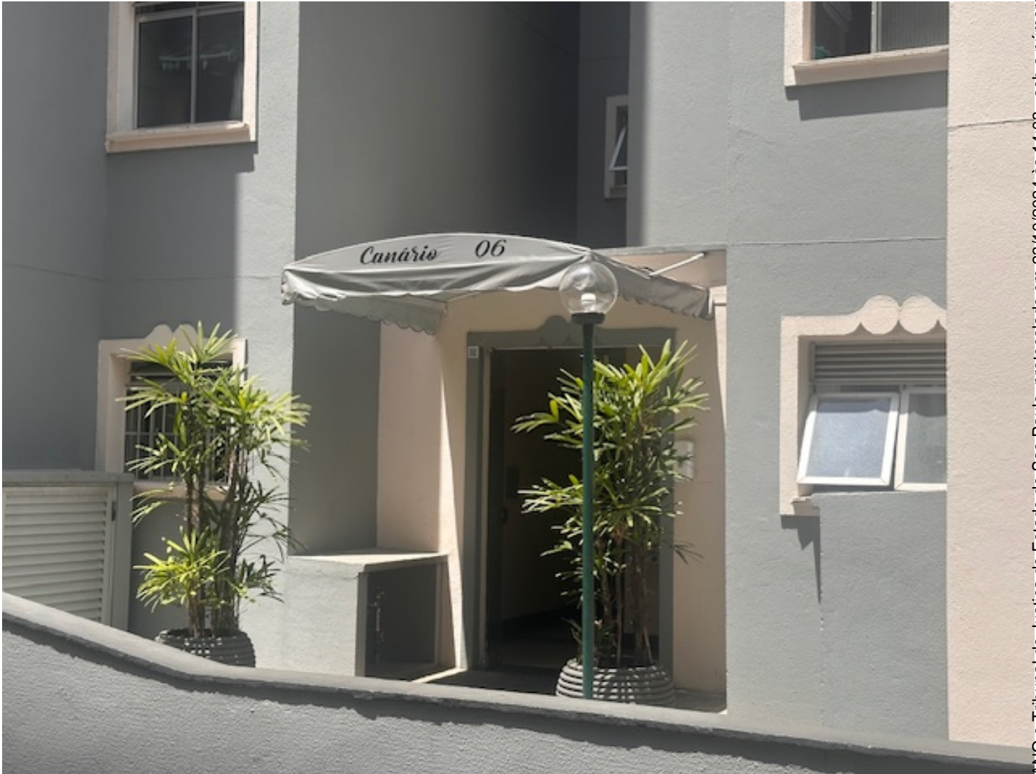
Foto 14: Vista da entrada do Bloco 6 do Condomínio Morada dos Pássaros.
