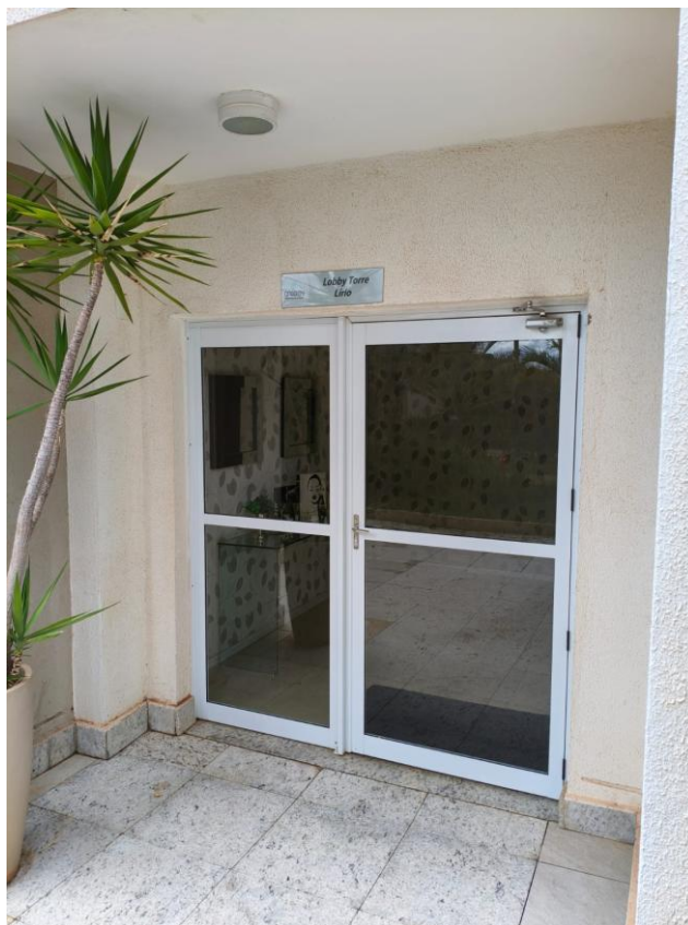
Entrada do Bloco
