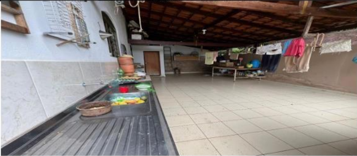
Cozinha e banheiro piso inferior:
